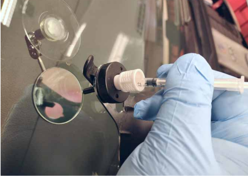
▲ Via de plunjer wordt de herstelhars aangebracht
