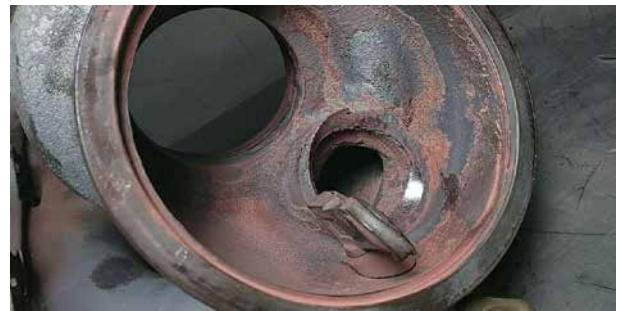
Foto 6 - Alles wijst op thermische overbelasting, kijk maar eens hoe het turbinehuis is vervormd
